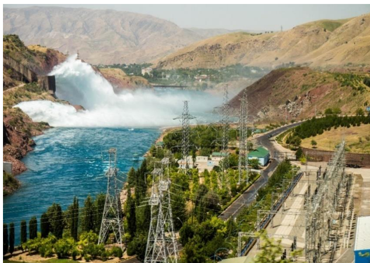
Фото 1: Фото 1. Водосброс Нурекской ГЭС и подстанция. ГЭС отвечает за более 75% энергоснабжения Таджикистана (Фото: Ронан Шенхав, 2016)
